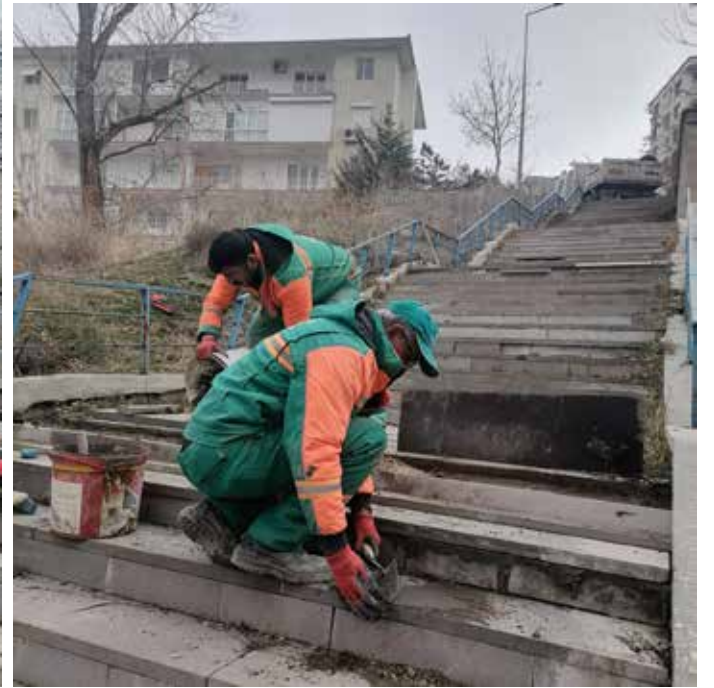
Aziziye mahallesine ait merdivenli sokağın bozulan basamakları onarıldı
